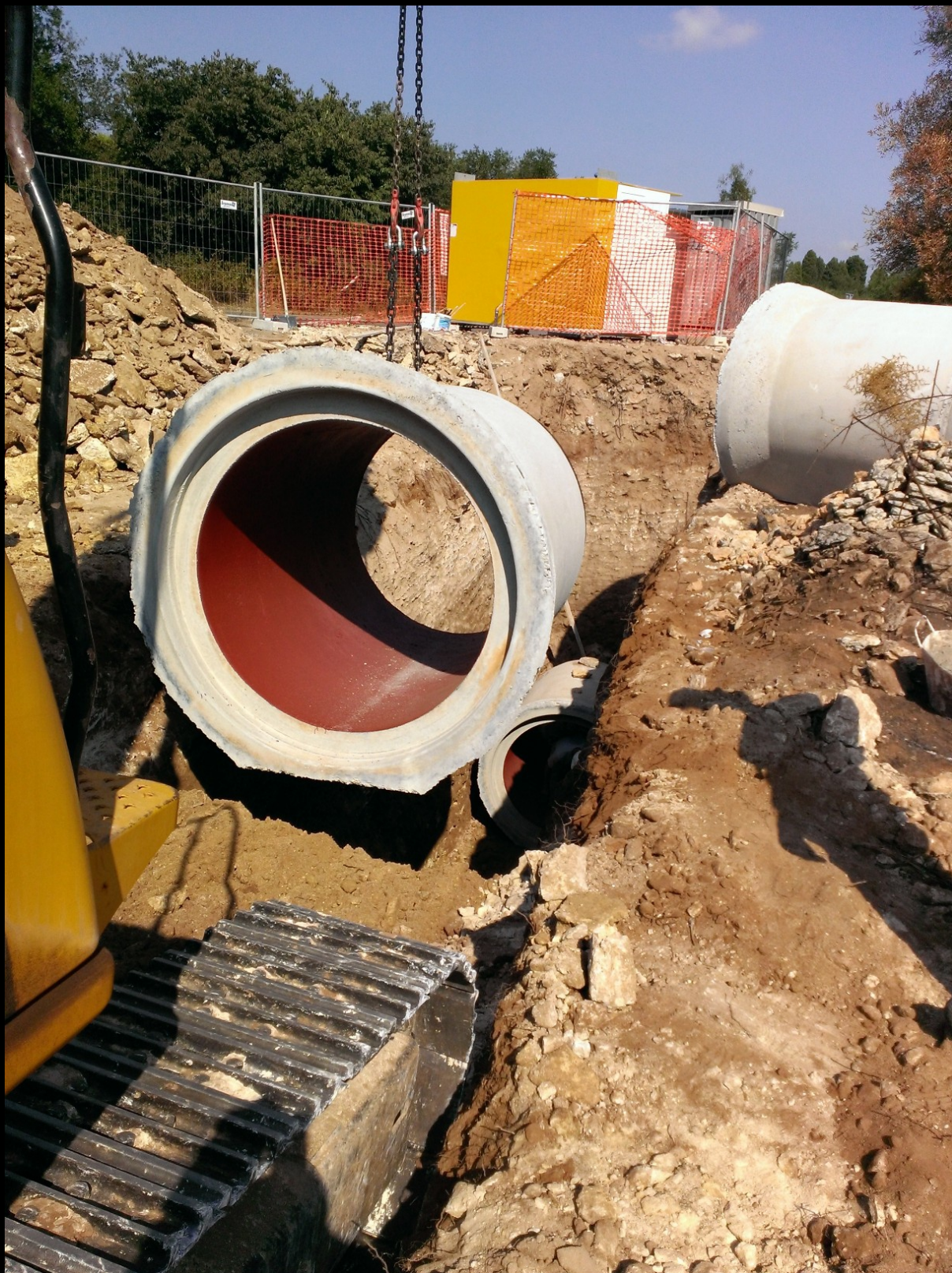
Rilievi e tracciamenti per la nuova condotta fognaria per le acque piovane in Borgagne Land survey and positioning for the new surface water sewer pipeline in Borgagne
