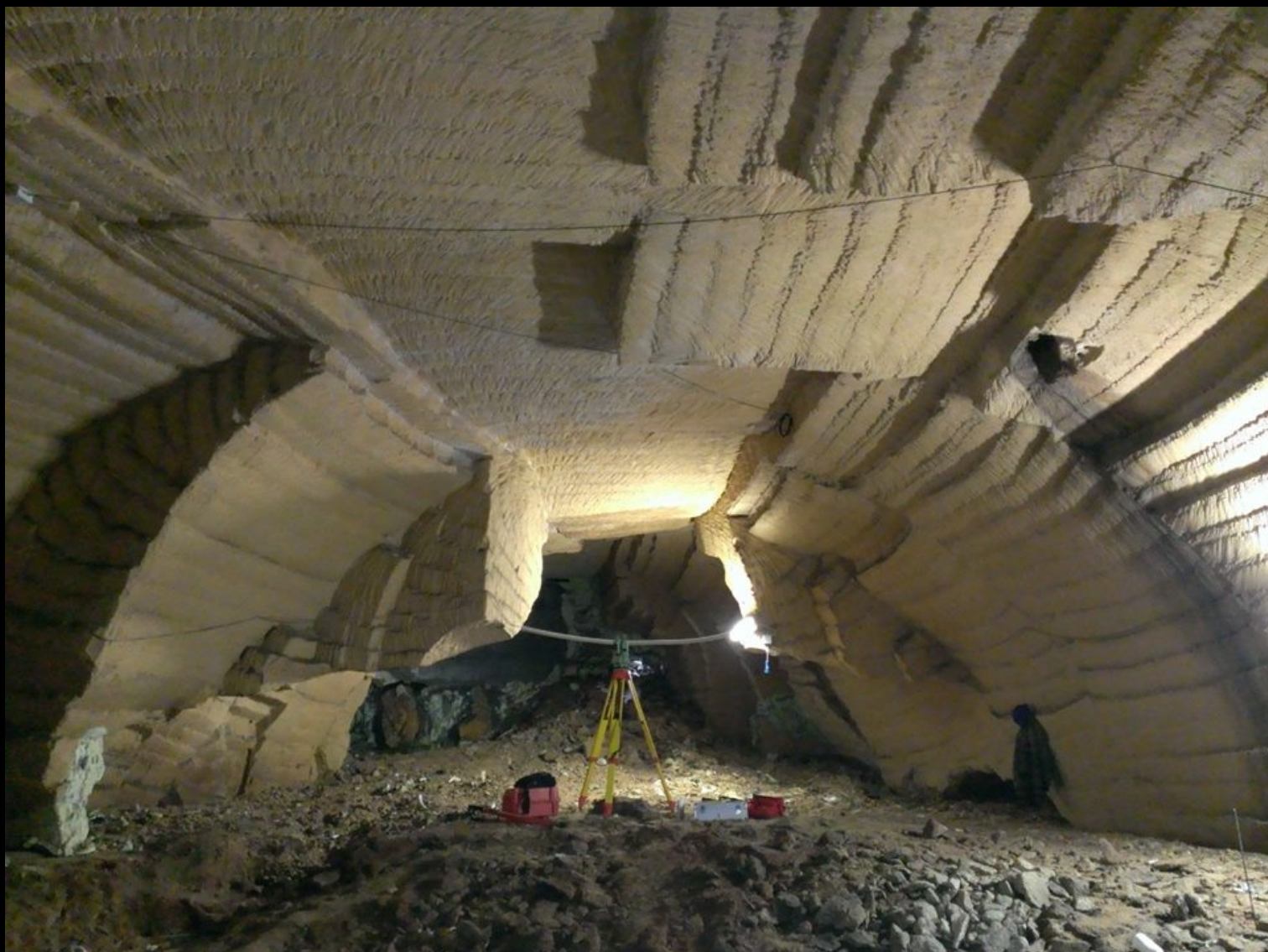
Città di Gallipoli, rilievo e tracciamento di strutture all'interno delle cave ipogee di via Firenze.
