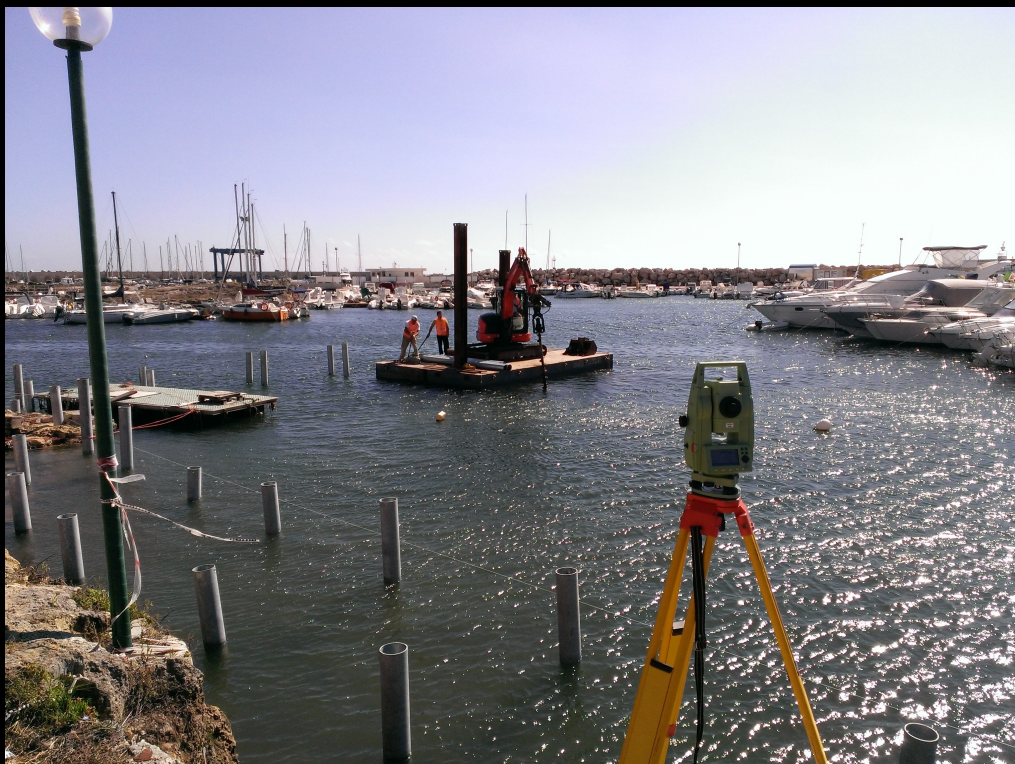
Rilievi e tracciamenti per i nuovi moli del porto di San Foca Marine survey and positioning for the new piers of the port in San Foca
