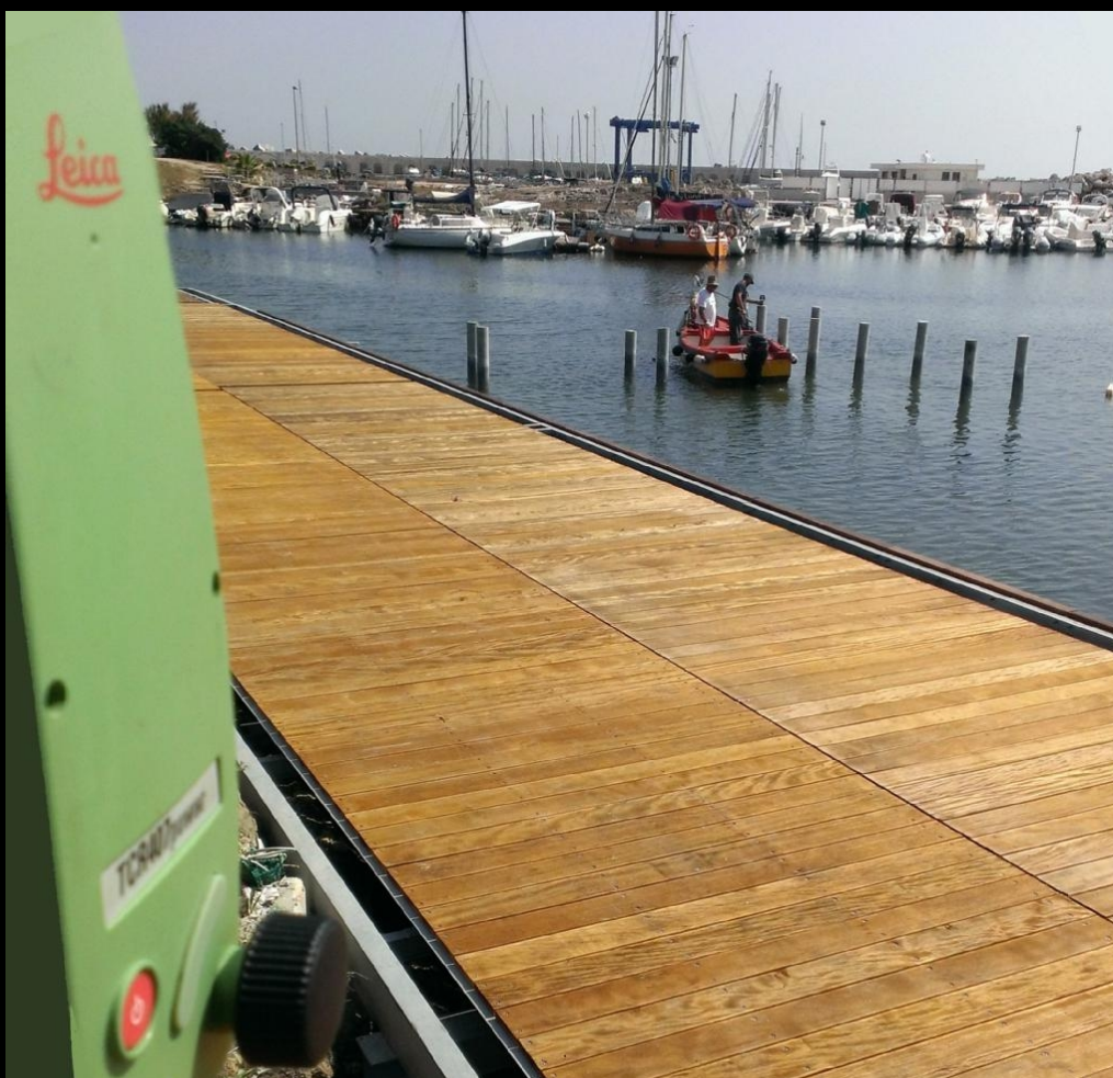
Rilievi e tracciamenti per i nuovi moli del porto di San Foca Marine survey and positioning for the new piers of the port in San Foca
